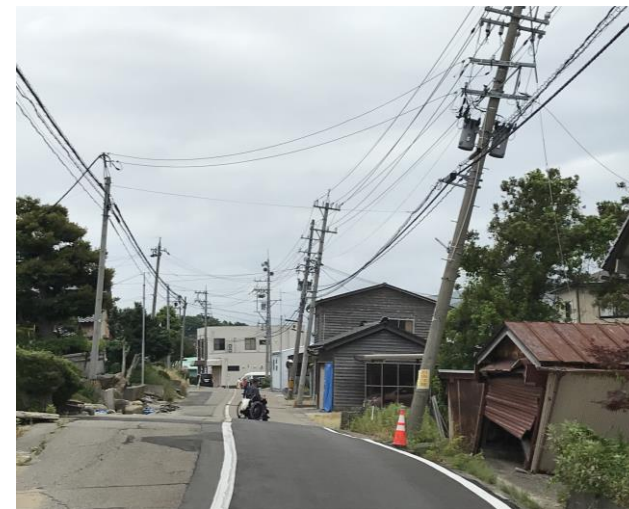
↑液状化により道が波打つ（内灘町にて）：6月撮影
