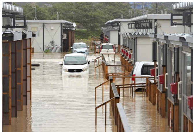
大雨で浸水した輪島市の仮設住宅 2024年9月22日読売新聞より
