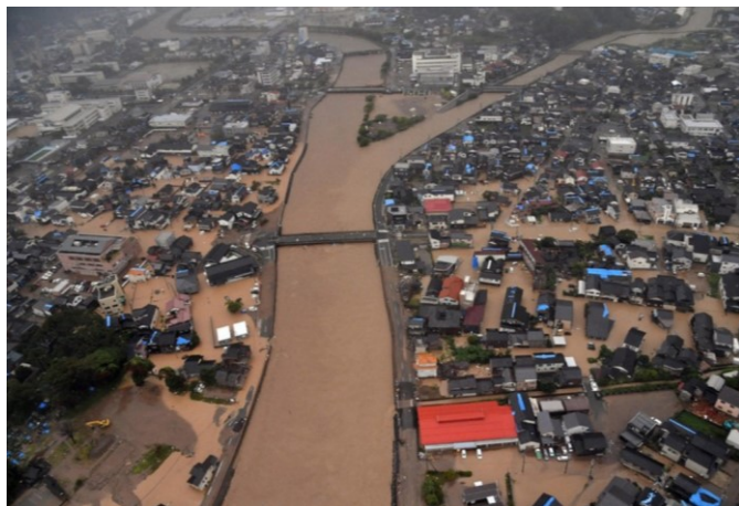
河原田川の氾濫で冠水した石川県輪島市の市街地 2024年9月21日毎日新聞より
