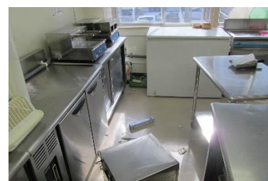
もぐもぐの落下した厨房機器
