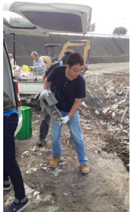
車両に瓦礫を積み込み、処理場まで運んでいる様子
